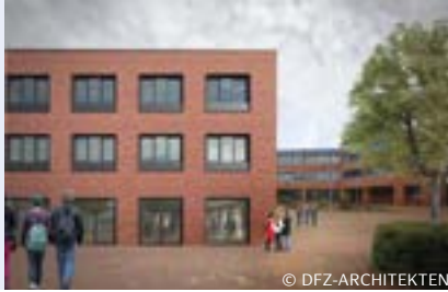
Berufliche Schule Anlagen- und Konstruktionstechnik am Inselepark (BS 13)
